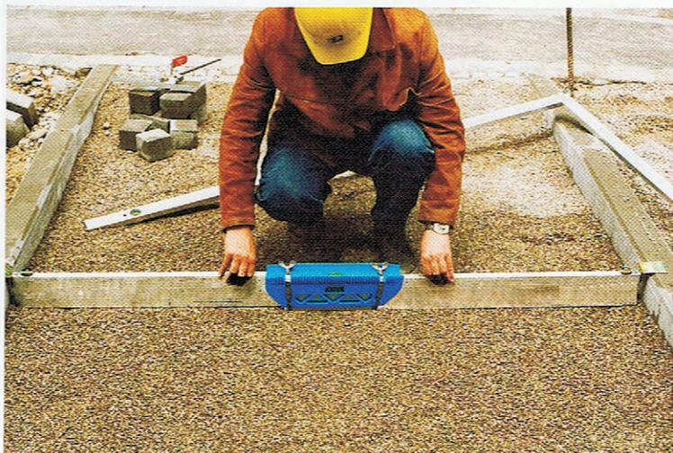
Beim Anlegen von Flächen, Wegen und Terrassen müssen Kies, Split und Sand abgezogen werden. Hier bietet die Wörle-Abziehschiene großen Komfort, da sie sich stufenlos in Länge und Höhe verstellen lässt. Die Auflagehöhe kann zwischen 0 und 12 cm verstellt werden und mithilfe der Horizontallibelle ist eine exakte Gefälleinstellung möglich. Die Abziehschiene ist nun in verbesserter Ausführung erhältlich. So wurde die Konstruktion der Spannschellen wei-
